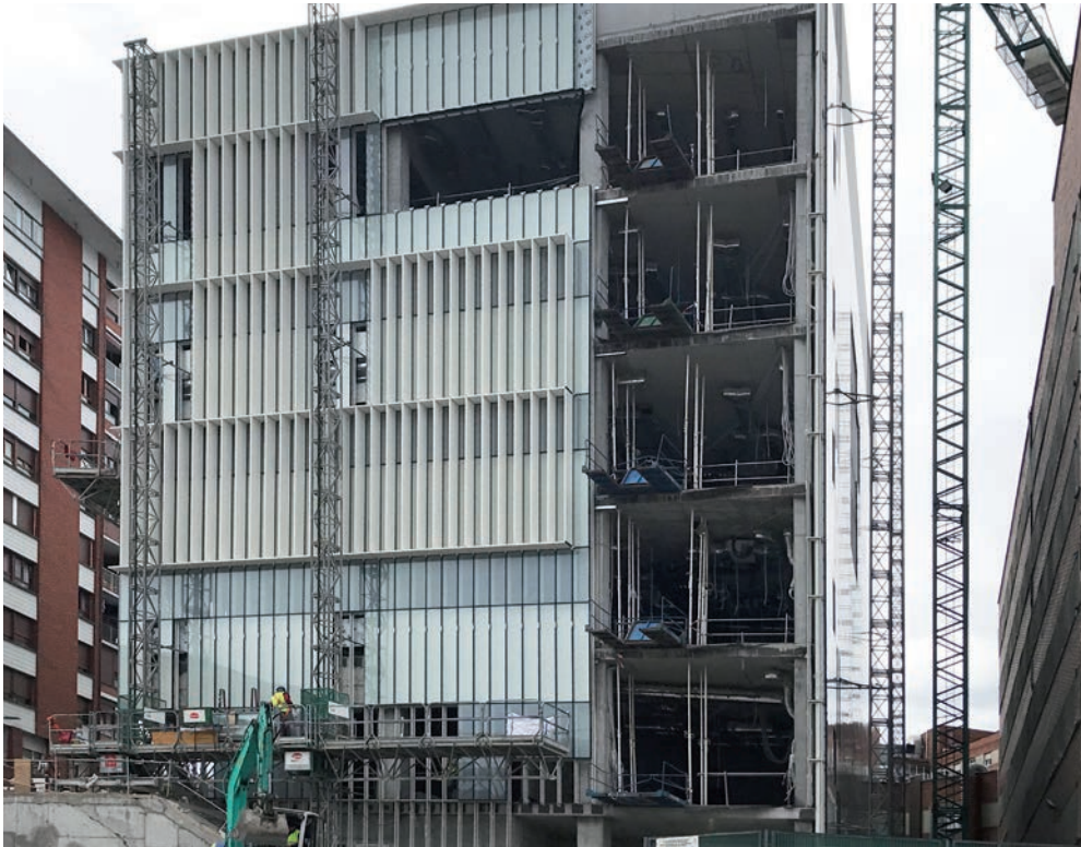
Un momento de la ejecución de la fachada, llevada a cabo por Riventi. En su desarrollo y ejecución se empleó el sistema R70ST, de esta firma. Foto: Riventi.
